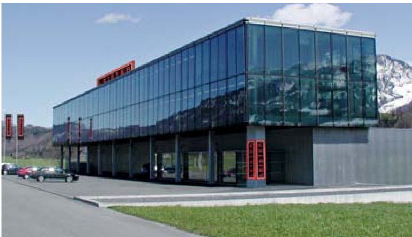
Здание корпоративного центра фирмы Leister, Кегисвиль, Швейцария
