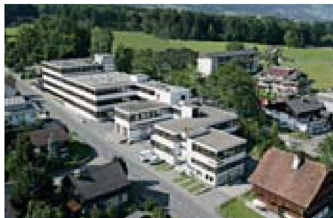
Производственные корпуса Leister Process Technologies, Кегисвиль, Швейцария
