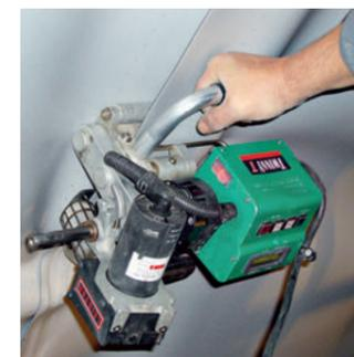
Сварка в туннеле геомембраны из ПВХ аппаратом TWINNY T
