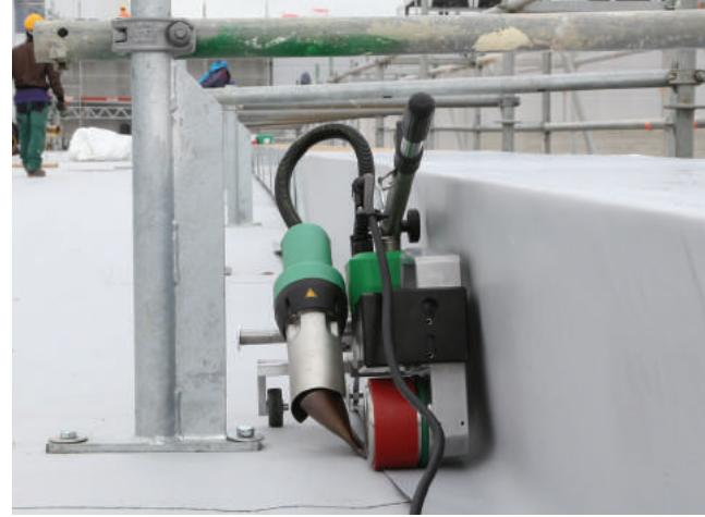
Автоматическая сварочная машина UNIROOF без проблем сваривает все труднодоступные места на кровле
