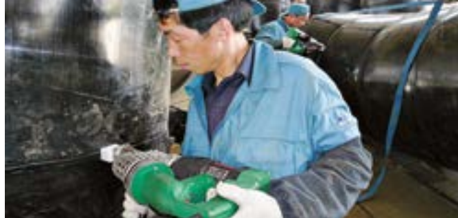
FUSION 2 при сварке резервуара в Китае
