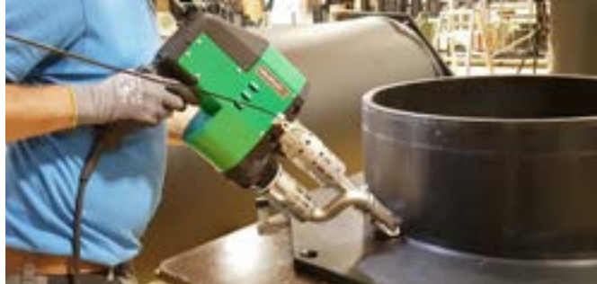
Мощный WELDPLAST S4 в работе
