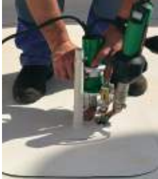
TRIAC DRIVE сваривает как на горизонтальных поверхностях,...
