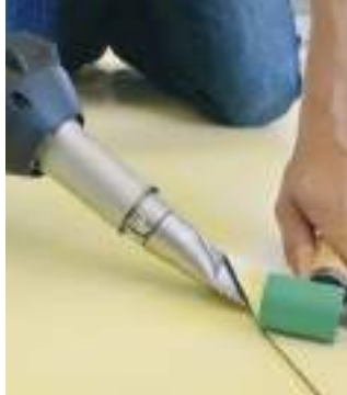
TRIAC ST: сварка рулонных полимерных материалов при использовании прикатного ролика
