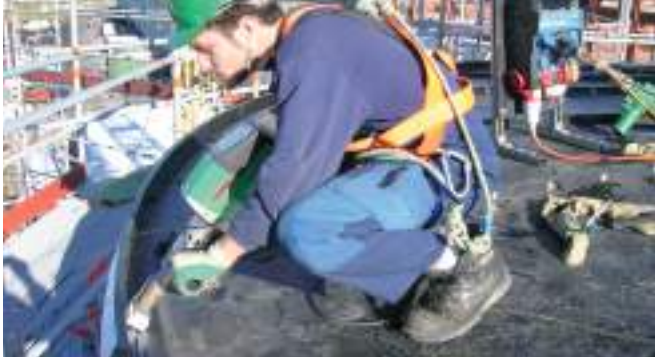
Мощный Weldplast S4 в работе
