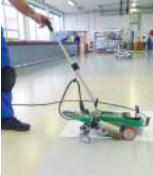
Постоянное качество сварки внахлѐст без образования складок
