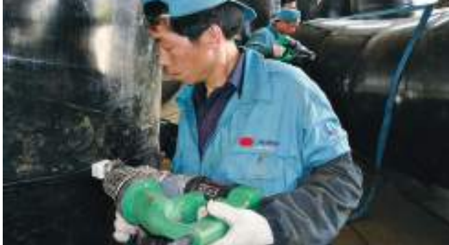
Экструдер FUSION 2 при сварке резервуара
