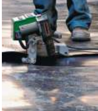
TWINNY T с комбинированным клином при сварке геомембраны из ПЭНД
