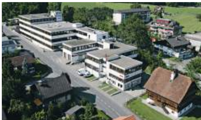
Leister Technologies AG, производственное здание, Кегисвиль, Швейцария
