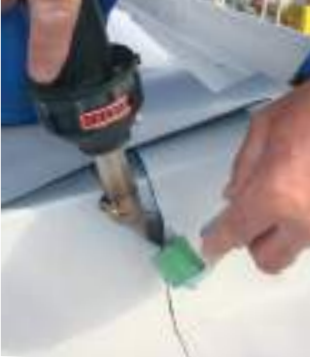
Маленький и лёгкий аппарат HOT JET S отлично подходит для сварки в узких и труднодоступных местах
